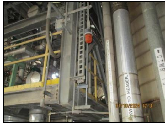
ภาพถ่ายที่ 2.2.2-33 อุปกรณ์ตรวจจับและเตือน (Detection & Alarm)
