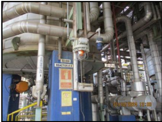
ภาพถ่ายที่ 2.2.2-33 อุปกรณ์ตรวจจับและเตือน (Detection & Alarm)
