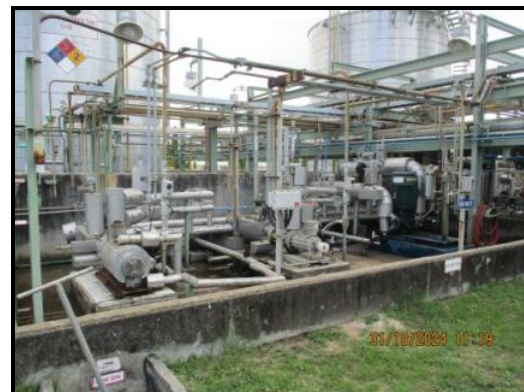
ภาพถ่ายที่ 2.2.2-5 ระบบ Double Seal Liquid Buffer
