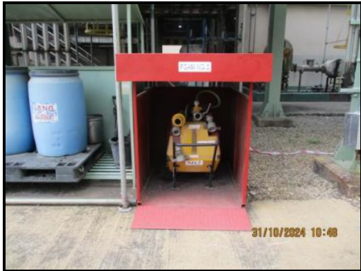
ภาพถ่ายที่ 2.2.2-30 ระบบดับเพลิงแบบเคลื่อนที่
