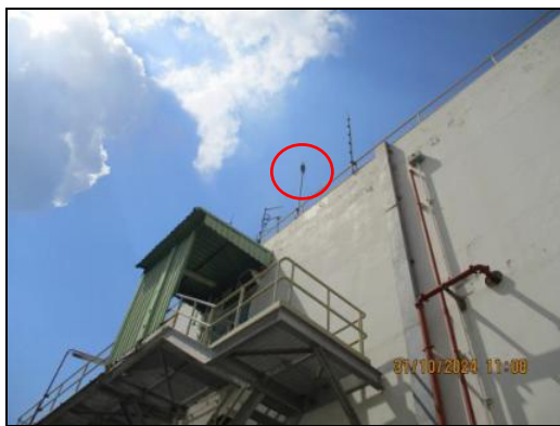
ภาพถ่ายที่ 2.2.2-43 Wind Sock และ Wind Speed Meter
