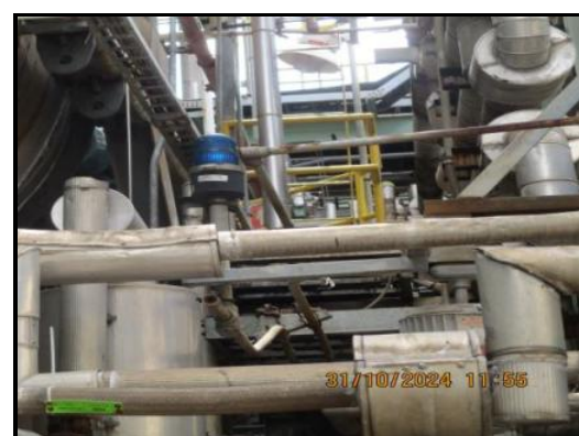
ภาพถ่ายที่ 2.2.2-27 Combustion Gas Detector และ Toxic Gas Detector
