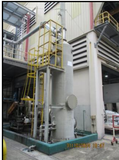
ภาพถ่ายที่ 2.2.2-4 Wet Scrubber ของเครื่อง Small Lot Extruder
