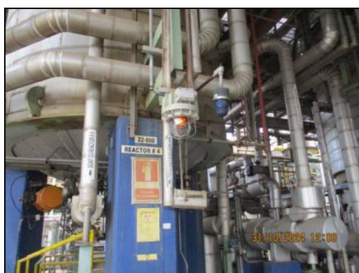
ภาพถ่ายที่ 2.2.2-6 อุปกรณ์ตรวจจับก๊าซและเตือน (Detection & Alarm)
