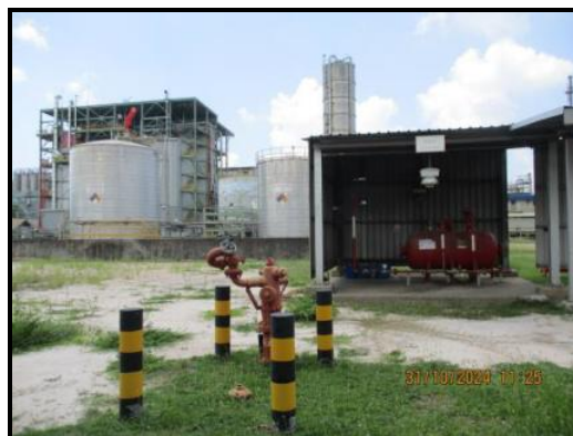
ภาพถ่ายที่ 2.2.2-40 ระบบดับเพลิงบริเวณถังเก็บสไตรีน และถังเก็บอะคริโลไนไตรล์
