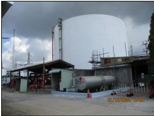
ภาพถ่ายที่ 2.2.2-42 ถังสำรองน้ำดับเพลิงและปั้มน้ำดับเพลิง
