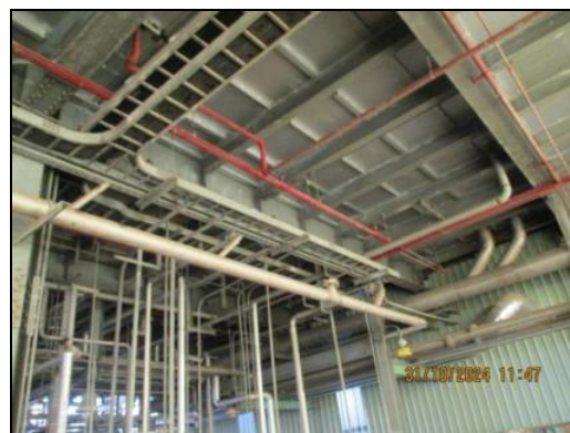
ภาพถ่ายที่ 2.2.2-41 ระบบน้ำดับเพลิงฉุกเฉิน
