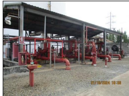
ภาพถ่ายที่ 2.2.2-42 ถังสำรองน้ำดับเพลิงและปั้มน้ำดับเพลิง
