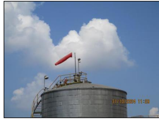
ภาพถ่ายที่ 2.2.2-43 Wind Sock และ Wind Speed Meter
