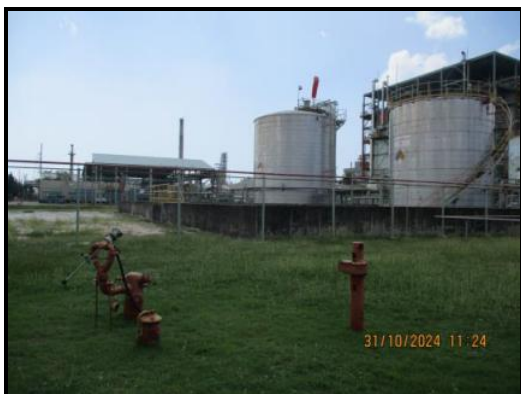
ภาพถ่ายที่ 2.2.2-40 ระบบดับเพลิงบริเวณถังเก็บสไตรีน และถังเก็บอะคริโลไนไตรล์
