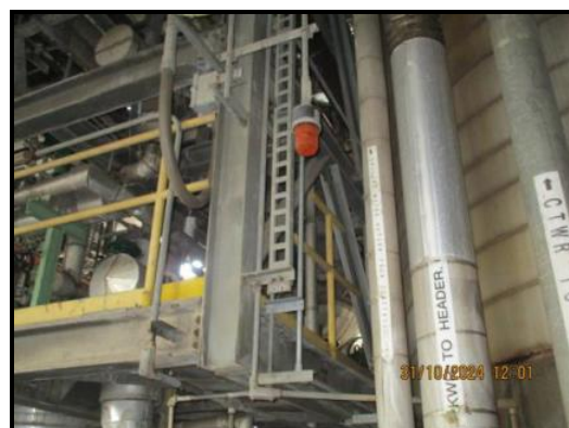
ภาพถ่ายที่ 2.2.2-6 อุปกรณ์ตรวจจับก๊าซและเตือน (Detection & Alarm)
